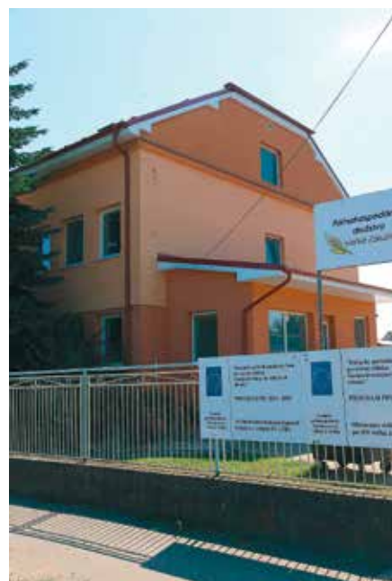
Pohľad na zrekonštruovanú administratívnu budovu, ktorá ponúka 26 bytov.
