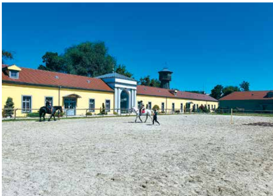
Do spoločensko-sportovo-relaxačného areálu patrí aj citlivo zrekonštruovaná károlyovská koniareň. V pozadí vidno tiež zrekonštruovanú historickú drevenú vodáreň.
