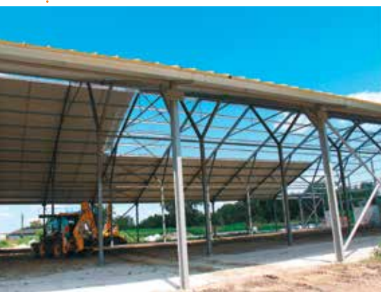
Stavba rastie každým dňom, čoskoro v nej nájde nový domov 440 dojníc.
