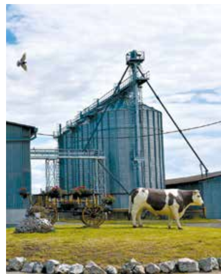
Po vstupe do areálu družstva zaujme návštevníka poriadok. V pozadí tri nové silá, každé s kapacitou 1 000 ton.
