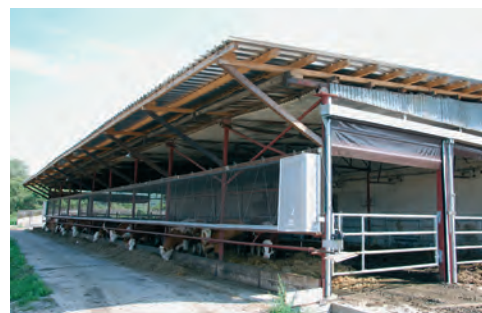
Obnovené priestory pre jalovice, to je nedávna investícia na hospodárskom dvore v Čiernom nad Topľou.
