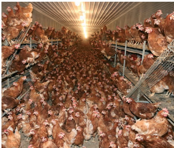
Hala nosníc zrekonštruovaná podľa najnovších štandardov.
